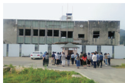
いわて学Ⅰでの旧大槌町役場（津波被害）視察
