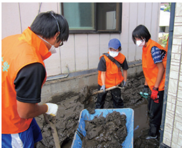
泥出し作業(久慈市)
