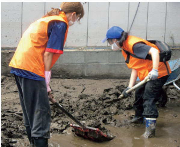
市街地での泥出し作業(久慈市)
