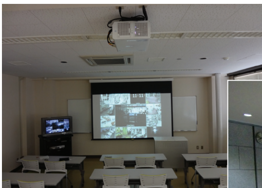
天吊り液晶プロジェクター設置（演習室）
